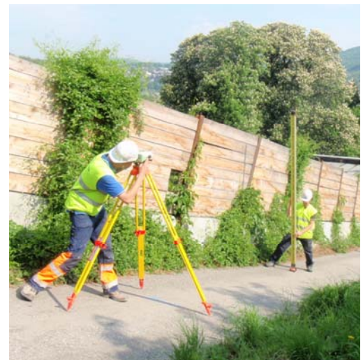
Präzisionsnivellement im steilen Gelände
