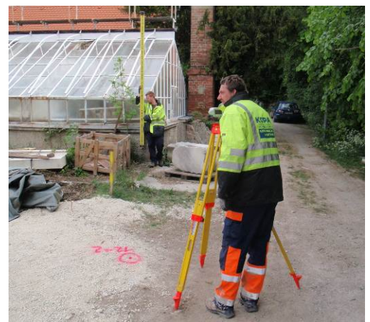
Setzungsnivellement am Lainzer Tunnel, Wien
