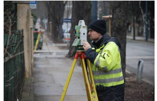
Vermessungsarbeiten am Lage- und Höhenplan der Bahnlinie Lainzer Straße-Oswaldgasse, Wien
