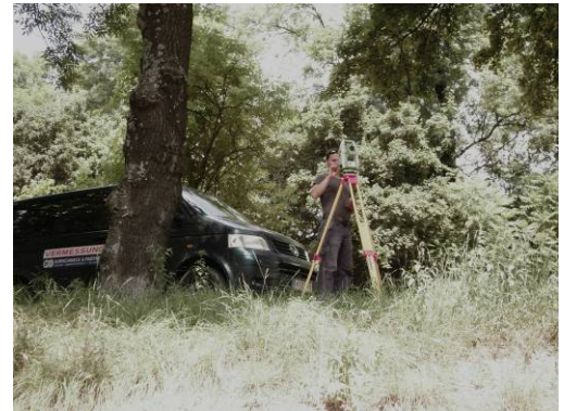
Vermessungsarbeiten für den Lage- und Höhenplan am Lainzer Tunnel West, Wien
