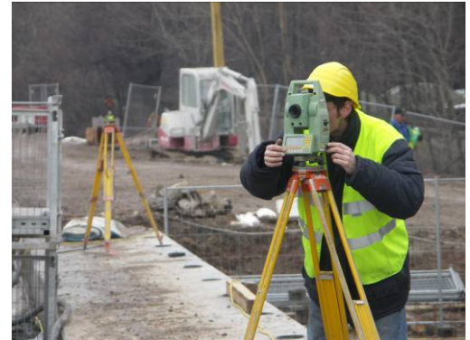
Trigonometrische Netzmessung und obertage am Lainzer Tunnel, Wien
