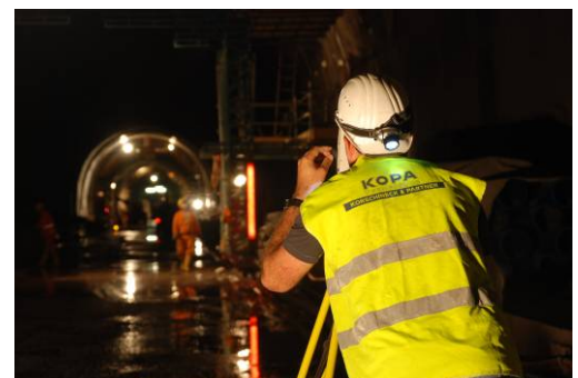
Trigonometrische Netzmessung untertage am Lainzer Tunnel, Wien
