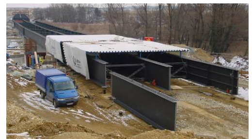
Bauvermessung Leithabrücke, A6 - Spange Kittsee, Niederösterreich
