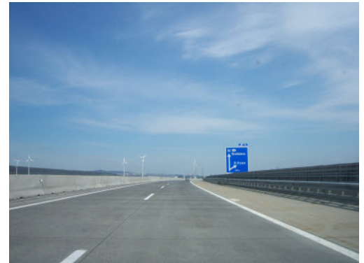
Vermessung A6-Nordostautobahn, Niederösterreich
