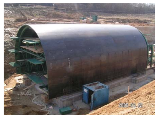
Bauvermessung TF6 Tullnerfeld, ÖBB Neubaustrecke Wien - St. Pölten, Niederösterreich
