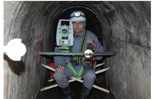
Kanalvermessung für den Lainzer Tunnel, Wien
