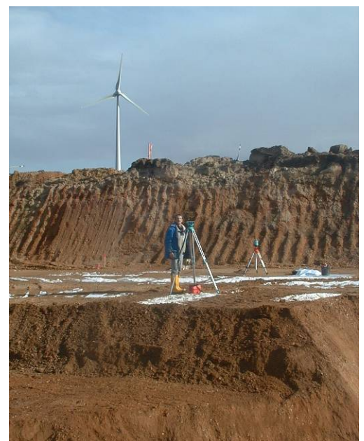
Vermessung Erdbauarbeiten an der Spange Kittsee, Niederösterreich
