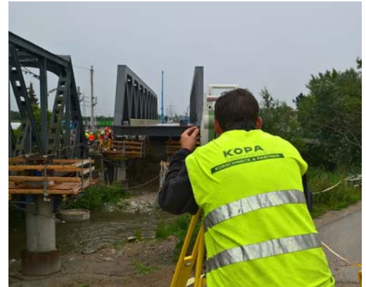
Überwachung eines Brückeneinschubes an der Pottendorfer Linie, Niederösterreich
