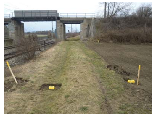
Freigelegte Grenzpunkte vorbereitend für die Grenzverhandlung
